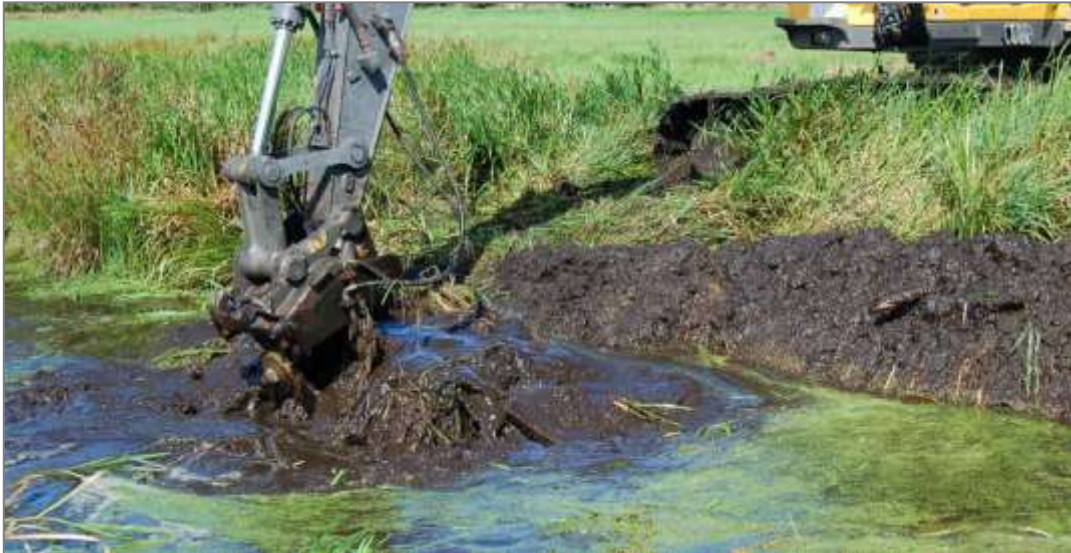
Foto boven: groot onderhoud gepleegd aan een (drink)poel. Onder: het verwijderen van de baggerlaag uit een (grote) poel.
